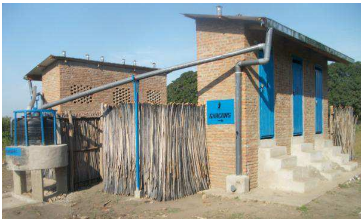
Latrines réalisées à l'Ecole Primaire de Maramvya II
