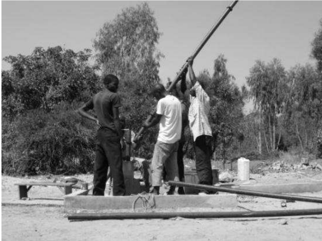
Travaux sur le forage de Maramvya 12
