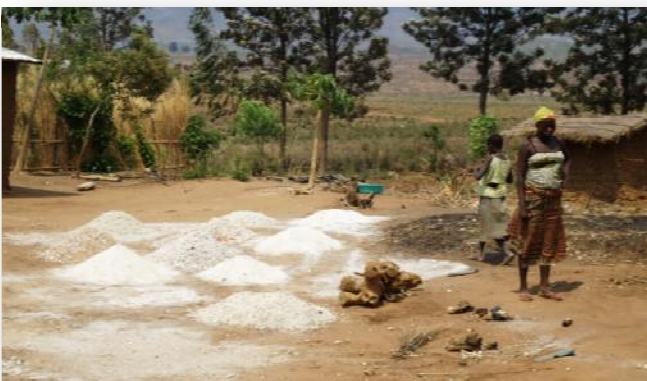
L'ALV, Apport Local Valorisé, est la contribution des ménages à la construction de leur latrine. Il est constitué la plupart du temps de sable et de gravier qui sert à la construction de la dalle de latrine.
