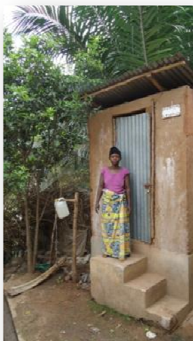
Une bénéficiaire pose à côté de sa latrine. En arrière-plan, le système de lavage des mains, indispensable pour « couper » les routes de contamination des maladies diarrhéiques. .
